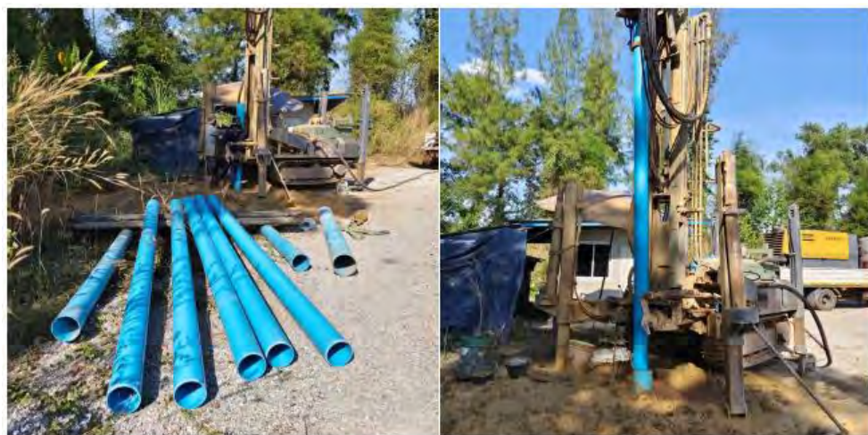
รูปที่ 15 การติดตั้งท่อกันพัง ณ หลุมเจาะ DHW-1
