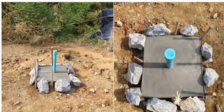
รูปที่ 22 เทฐานคอนกรีตรอบปากหลุม DHW-1
