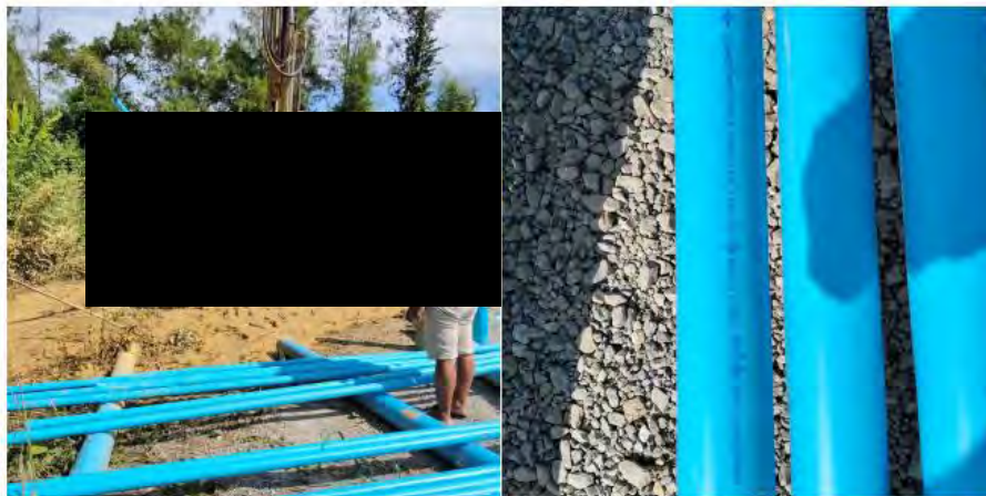
รูปที่ 21 ติดตั้งท่อเจาะร่อง ขนาด 2 นิ้ว ตลอดความลึกถึงก้นหลุม ณ ตำแหน่งหลุม DHW-1
