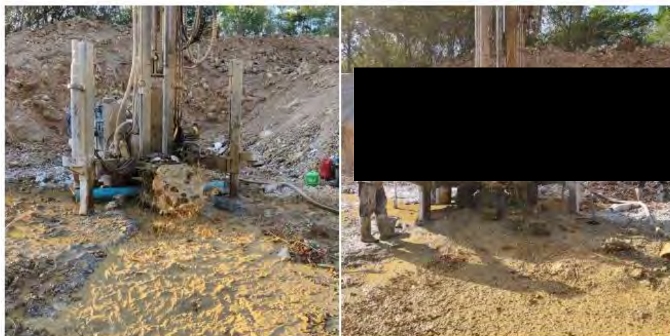
รูปที่ 26 ขณะเจาะเจอชั้นหินดินดานฝู ที่ความลึก 37.00 - 38.00 เมตร ที่ให้ปริมาณน้ำมาก
