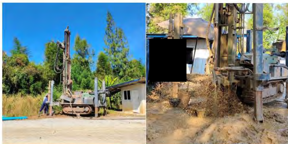
รูปที่ 16 ขณะเจาะสำรวจที่ระดับความลึก 23.00 เมตร รอยต่อระหว่างชั้นดินกับชั้นหิน
