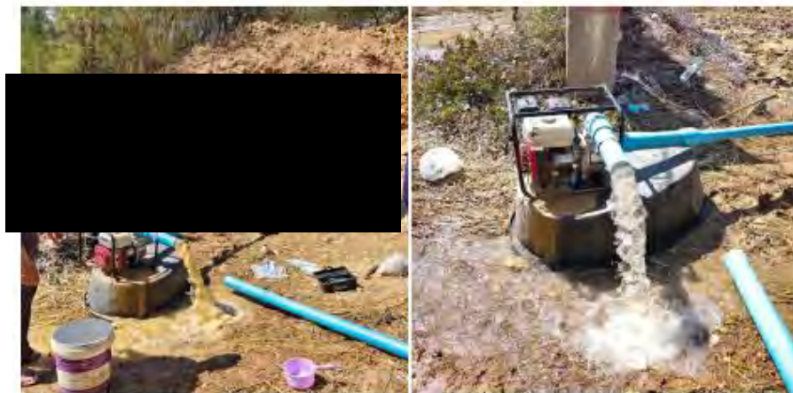
รูปที่ 41 การสูบน้ำทดสอบปริมาณน้ำ
