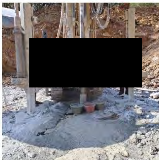
รูปที่ 24 สภาพการเจาะหินปูนช่วงความลึก 9.00 - 18.00 ณ หลุมเจาะ DHW-2
