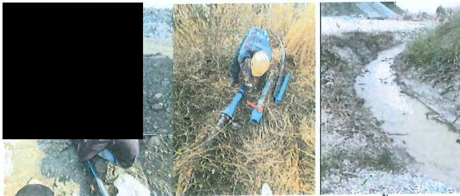
การต่อท่อน้ำจากบ่อเหมืองเพื่อสูบน้ำออกลงสู่รางระบายน้ำ
