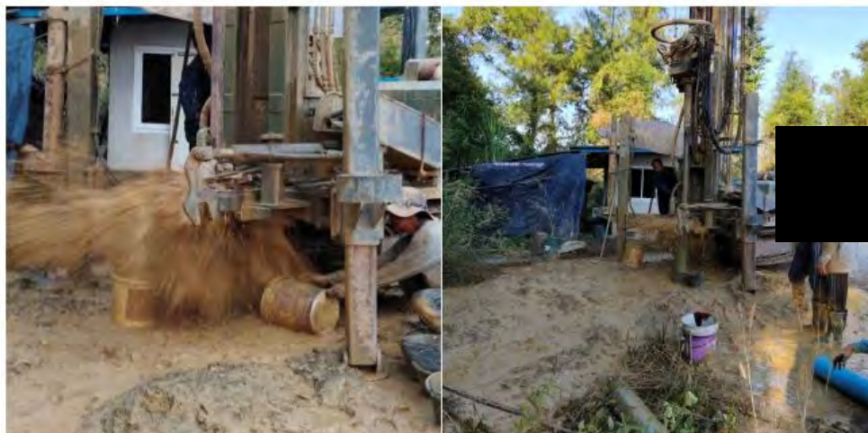
รูปที่ 17 ขณะเจาะสำรวจในชั้นหินดินดานผู้ ที่ให้ปริมาณน้ำมาก
