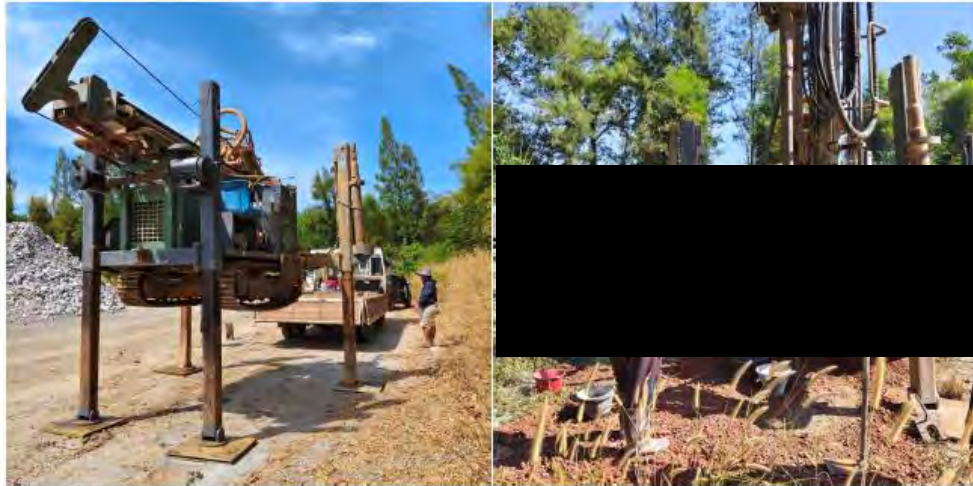
รูปที่ 14 ขณะติดตั้งเครื่องเจาะ ณ ตำแหน่งหลุมเจาะ DHW-1
