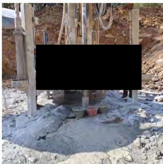
รูปที่ 25 สภาพการเจาะหลุม DHW-2 ที่ความลึก 19.00 เมตร เริ่มเจอน้ำปริมาณเล็กน้อย
