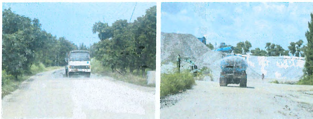
ติดตั้งสเปรย์ท่อน้ำบริเวณเส้นทางขนส่งภายในเหมือง และเพิ่มจำนวนเที่ยวรถบรรทุกน้ำริมเส้นทางป้องกันฝุ่นละออง
