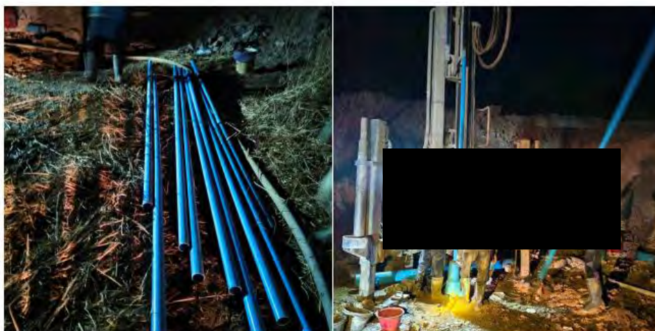
รูปที่ 31 ติดตั้งท่อเจาะร่อง ขนาด 2 นิ้ว ตลอดความลึกถึงก้นหลุม ณ ตำแหน่งหลุม DHW-2
