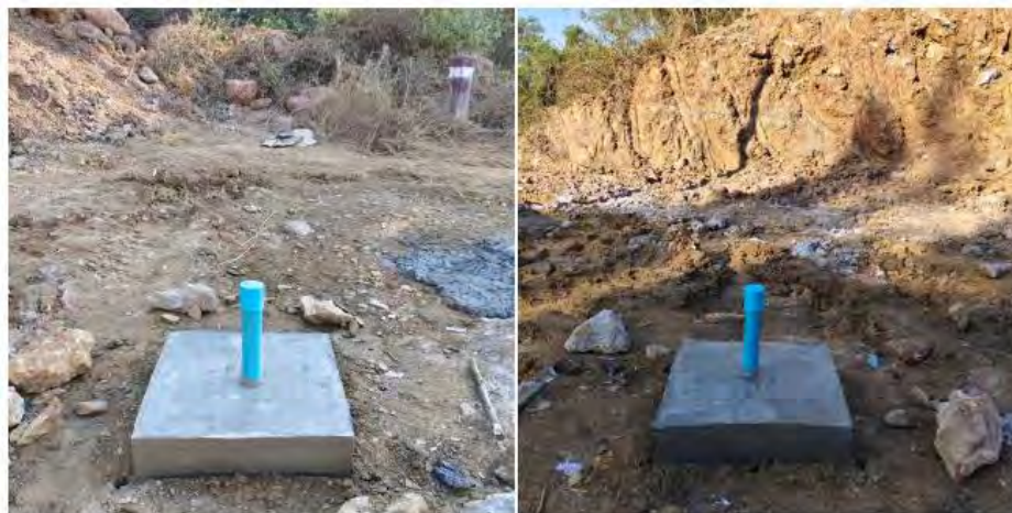
รูปที่ 32 เทฐานคอนกรีตรอบปากหลุม DHW-1
